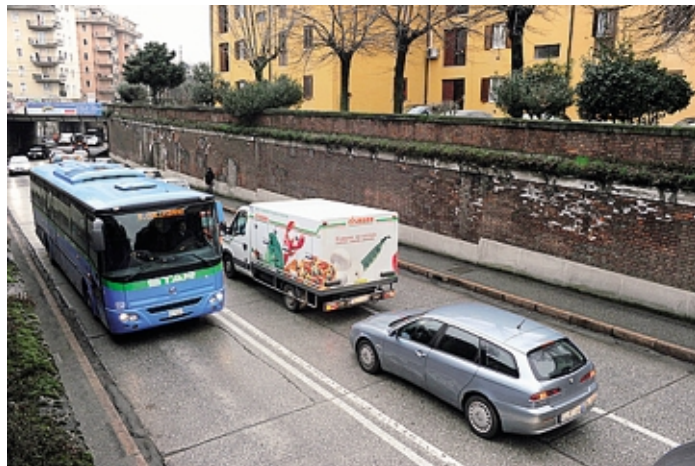
Il sottopasso di via San Colombano, dove saranno effettuati i lavori
