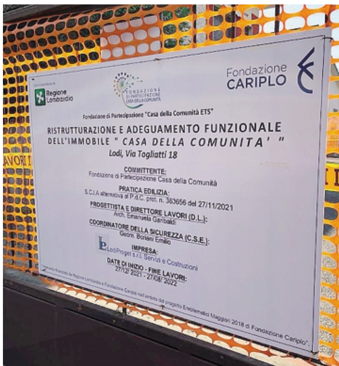
Il cantiere in via Togliatti per la realizzazione della casa della comunità
