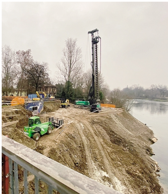
Procedono i lavori per la nuova campata, da marzo il ponte verrà chiuso
